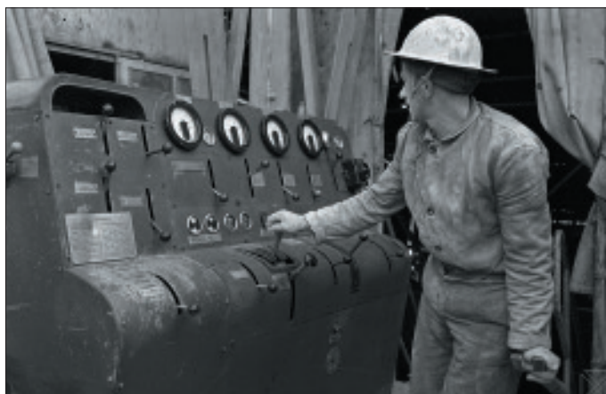
Perforando un pozo en Castillo. 1960. ARQUÉ. AMVG. / ARQ-1270_13(1).
